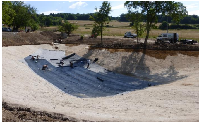
Požiarna nádrž Pliešovce
