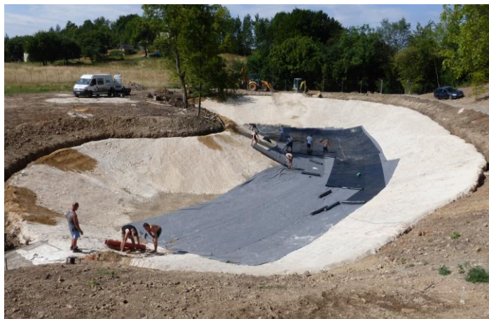
Požiarna nádrž Pliešovce
