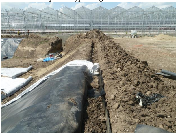
Zámok nádrže pred zásypom rigolu
