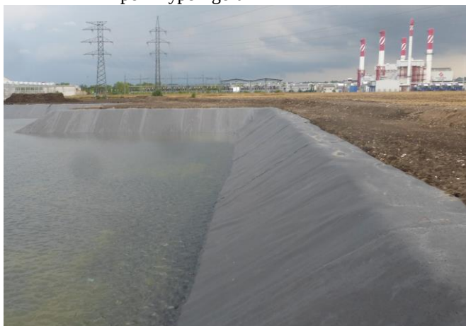
Zámok nádrže po zásype rigolu
