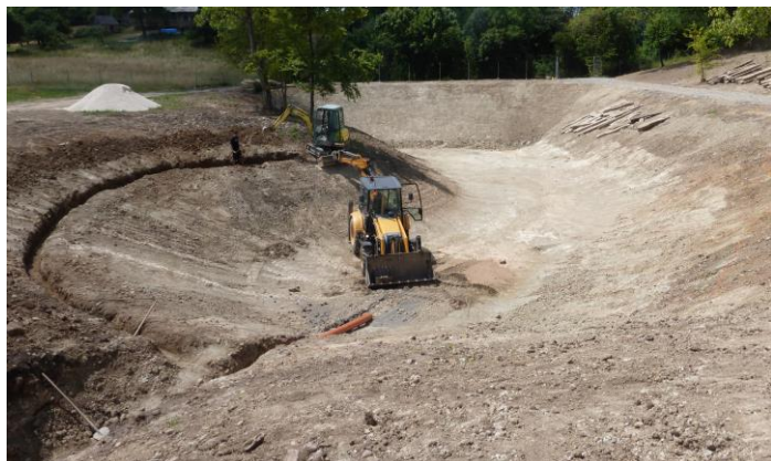
Požiarna nádrž Pliešovce
