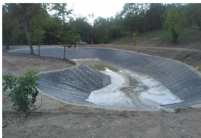
Požiarna nádrž Pliešovce
