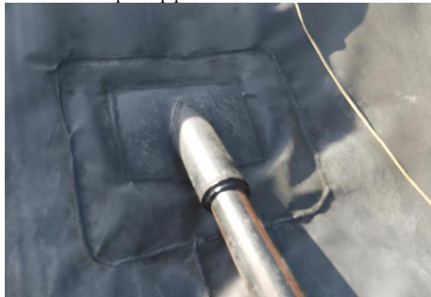
Sanie nádrže – prestup potrubia HDPE fólia
