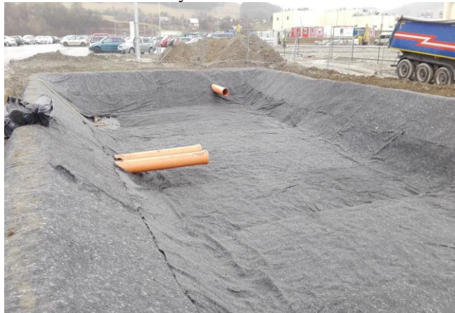
Retenčná nádrž INA Kysuce
