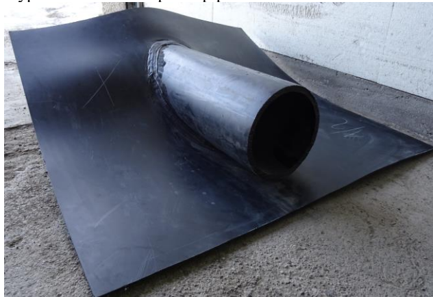
Výpust dno nádrže - prestup potrubia HDPE fólia
