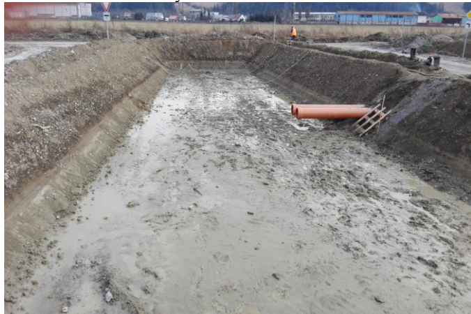
Retenčná nádrž INA Kysuce
